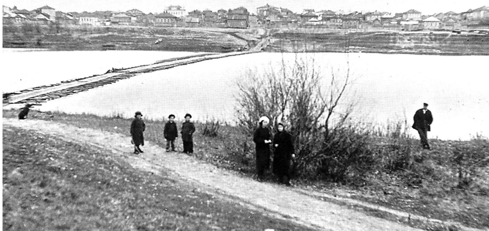
Общий вид поселка Николаевского со стороны Камышина. Мост через Резницкое озеро. 1948 год
