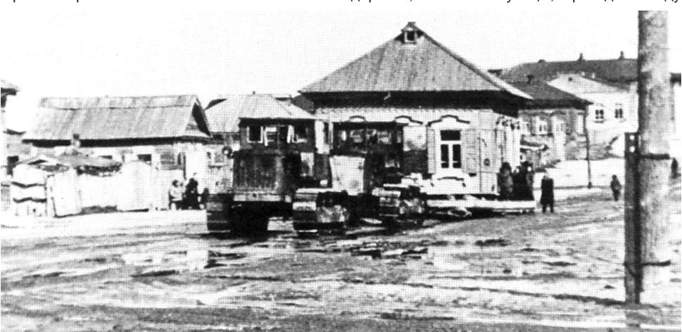
Перевоз домов из зоны затопления на новое место
