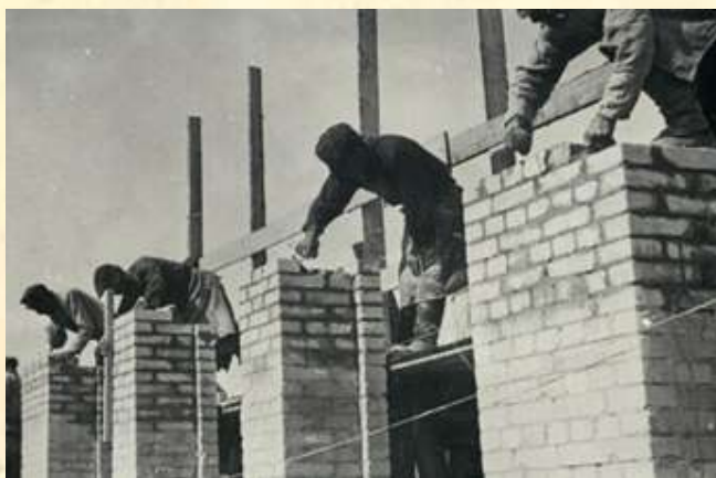
Кладка стен на строительстве метизного завода
