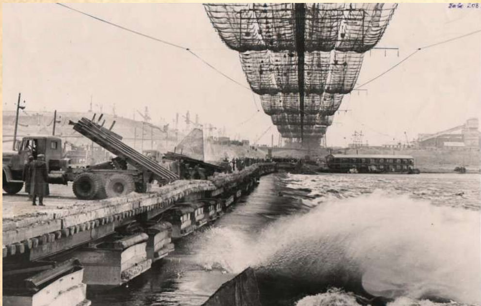
Перекрытие р. Волги, весна, 1955 г.
